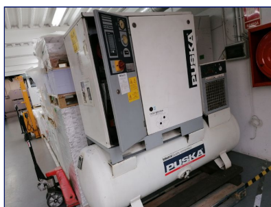
Compresor de tornillo 10 cv con secador y deposito
